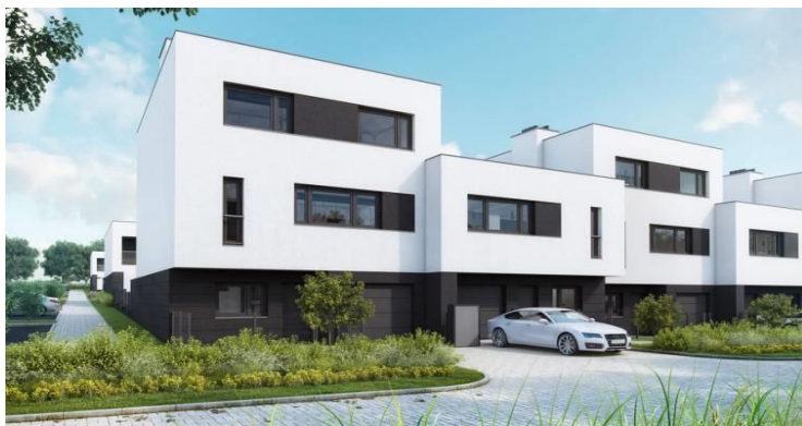
Łódź Chojny Park III (domy szeregowe) 29 domów Termin realizacji: II kwartał 2017 r.
