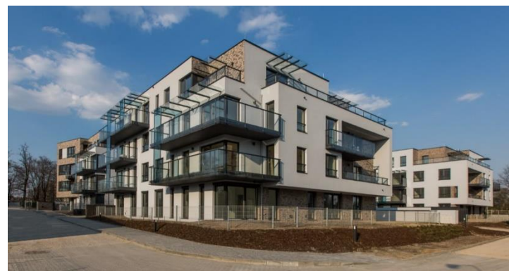
Kraków Lazurów Park Bronowice II (70 lokali)
